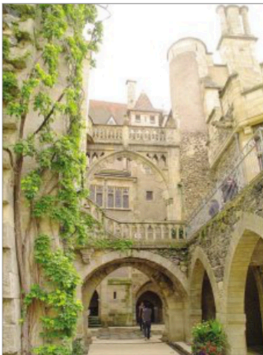
VISITE. La cour intérieure du château, avec ses nombreuses voûtes en arcades, la partie la plus ancienne. PHOTO DR
